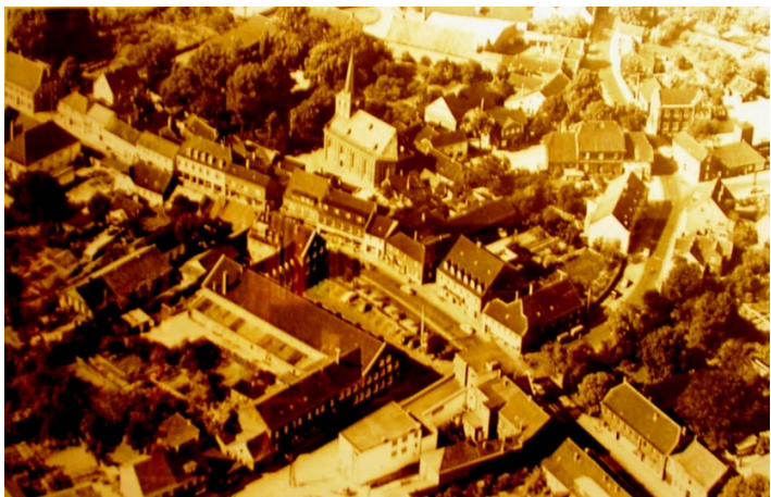
Luftbild, zeigt rechts den Verlauf der Kirchstraße bis zur Einmündung der Feldstraße, 1964 © N. Wehren.
